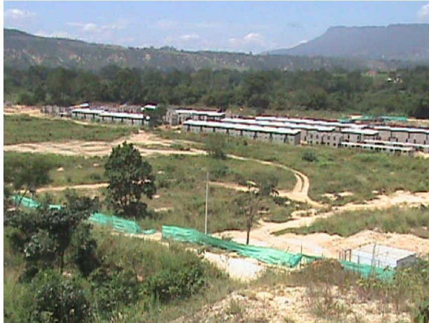
Fotografía 4.14 Ciudadela Nueva Girón. Sector en planicie de inundación
