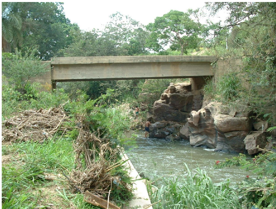
Fotografía 4.28. K21+588. Puente vehicular en vía a Zapatoca.
