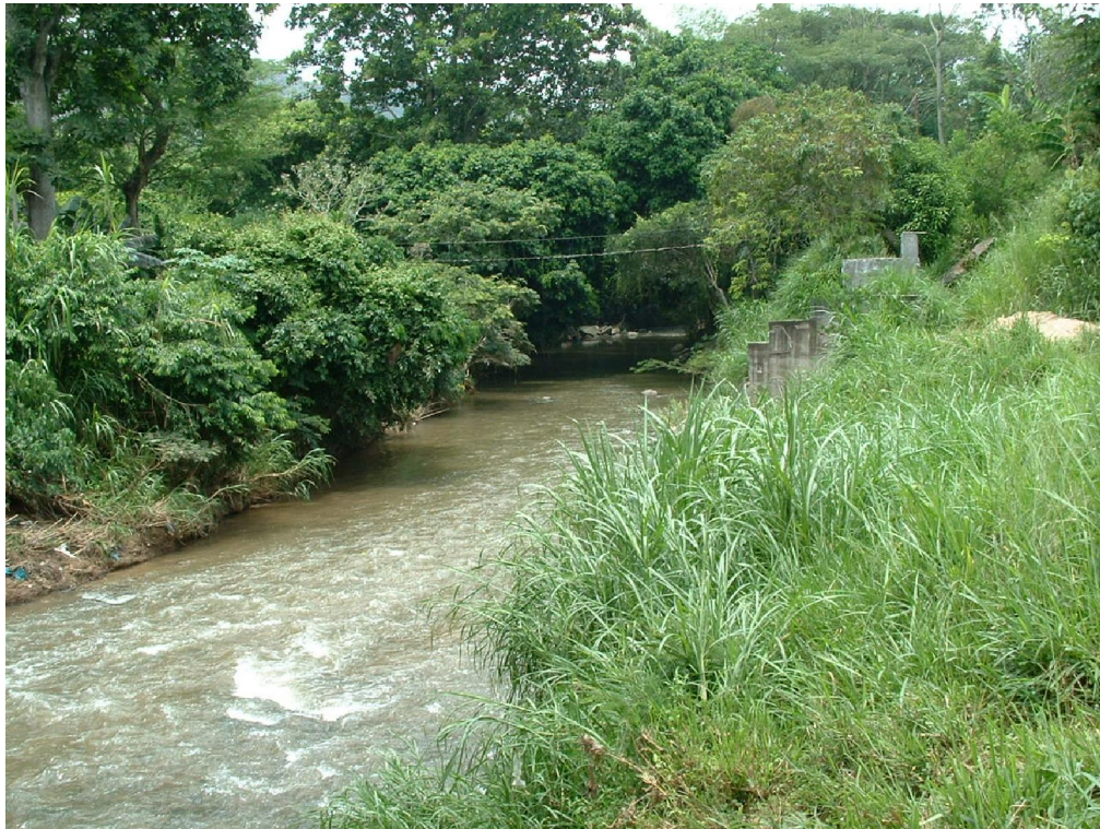
Fotografía 4.26. K12+352. Puente peatonal en Palogordo.
