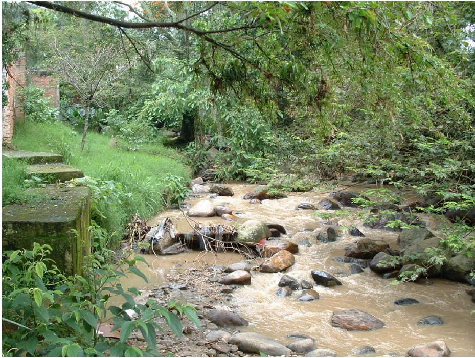
Fotografía 5.7 Sector Barrio BarroBlanco. A la izquierda el muro de protección de las viviendas
