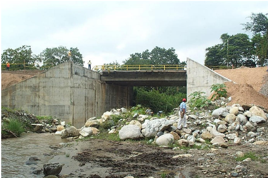
Fotografía 4.16 K0+355. Puente El Conquistador Vía Bucaramanga – Bogotá.
