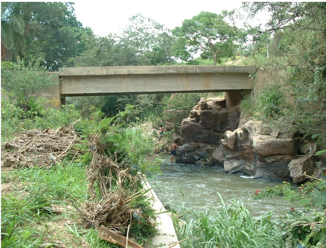
Fotografía 5.12 Puente vehicular sobre la vía a Zapatoca.
