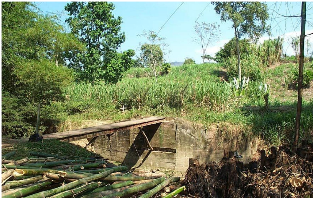
Fotografía 4.22. K5+340. Peatonal en confluencia de Río de Oro con Quebrada Grande.
