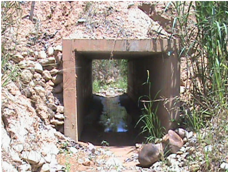
Fotografía 4.15 Box Culvert que desagua al Río de Oro, en Ciudadela Nueva Girón
