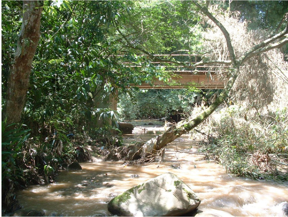
Fotografía 4.21. K4+026. Acceso a vía a Pajonalito.
