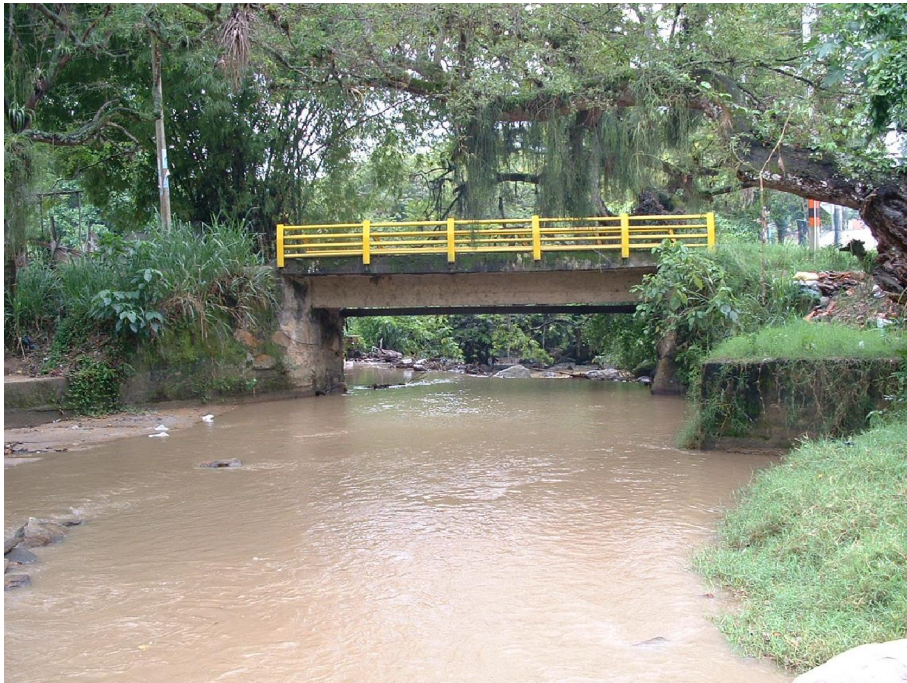
Fotografía 4.17 K0+811. Puente peatonal conexión Autopista con Piedecuesta. Urbanización Villas del Río.
