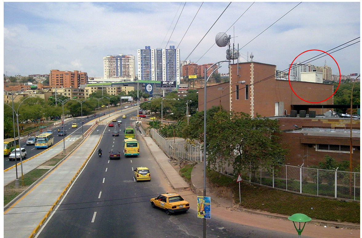
Estacion instalada en la Terraza del Edificio Telebucaramanga-Cañaveral
