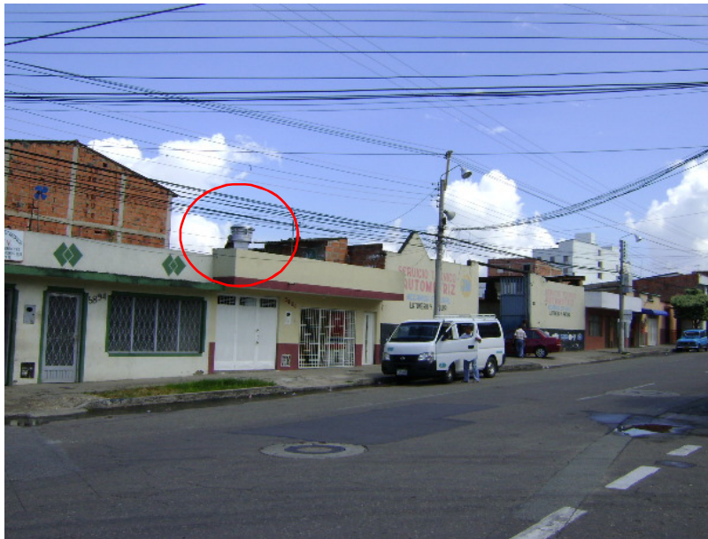
HiVol instalado en una vivienda del barrio Ricaurte
