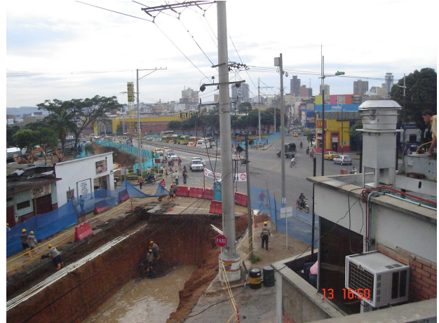
Fig 12. Foto intersección durante de la construcción del Túnel
