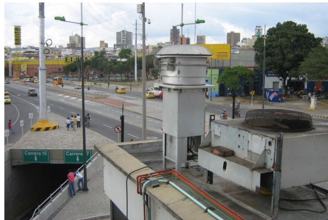
Fig 13. Foto intersección después de la construcción del Túnel
