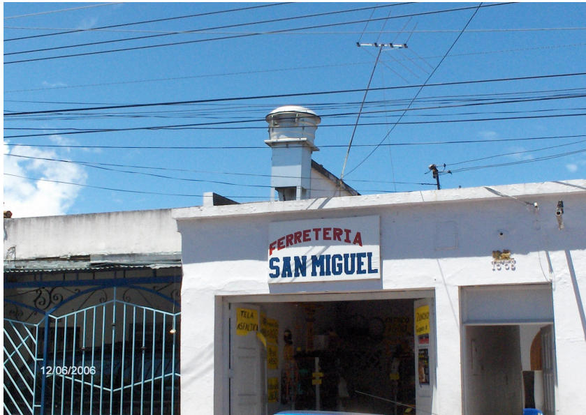
Vivienda del Barrio San Miguel
