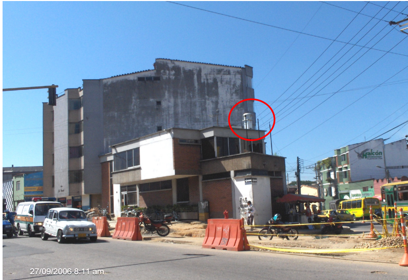
Central de Semaforización DTB
