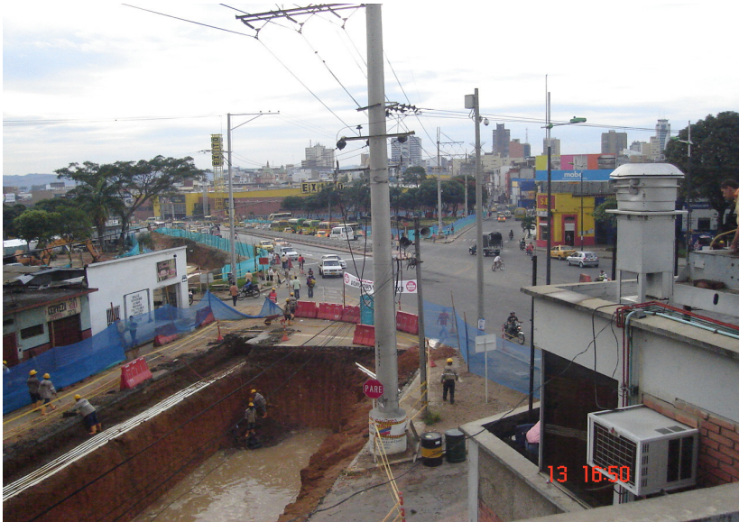
Panorámica desde la Central de Semaforzación DTB de la construcción del deprimido sobre la carrera 17
