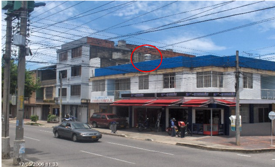
Vivienda del Barrio La Concordia
