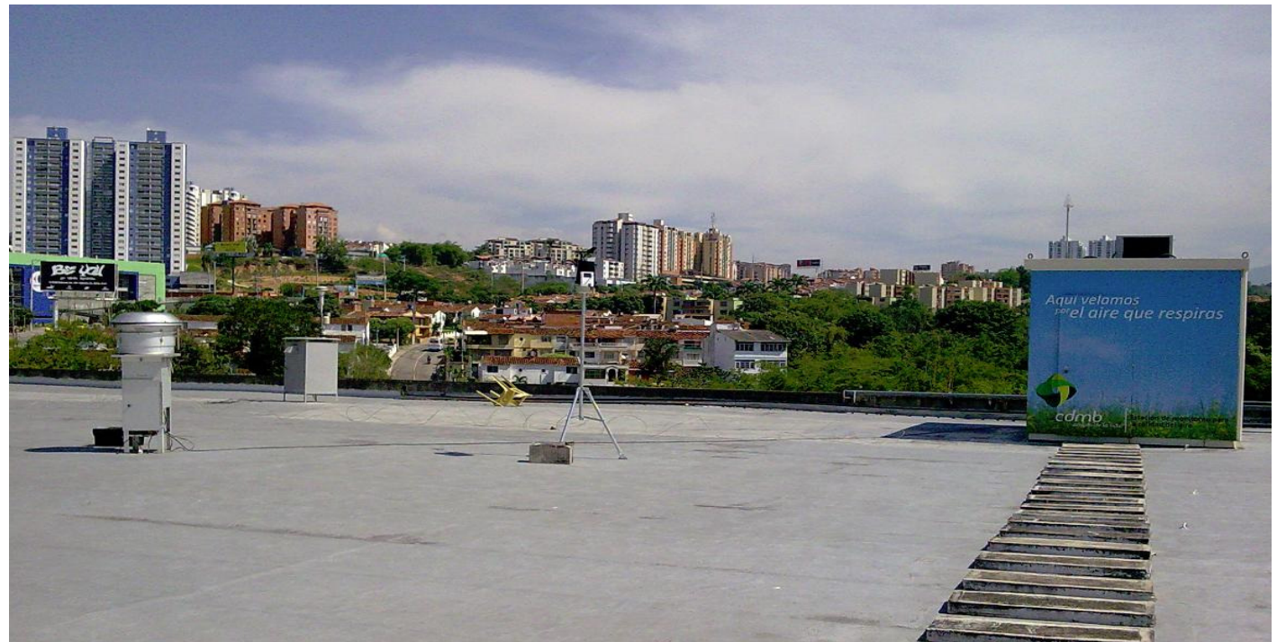
Estacion instalada en la Terraza del Edificio Telebucaramanga-Cañaverl
