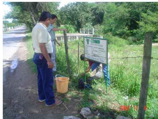
Instalación de letrero metalico
