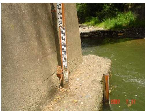
Limnómetro anclado a la aleta del puente
