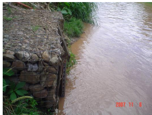
Después de realizado el mantenimiento
