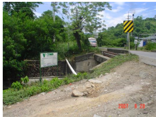
Instalación del letrero metálico.
