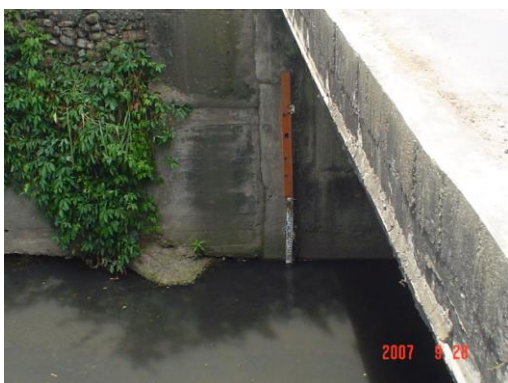
Limnómetro sobre el estribo del puente
