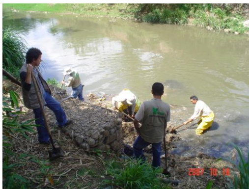
Realizando el mantenimiento
