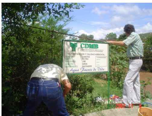
Instalación del respectivo letrero de ubicación.
