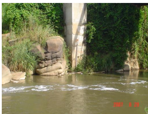
Limnómetro anclado al estribo del puente
