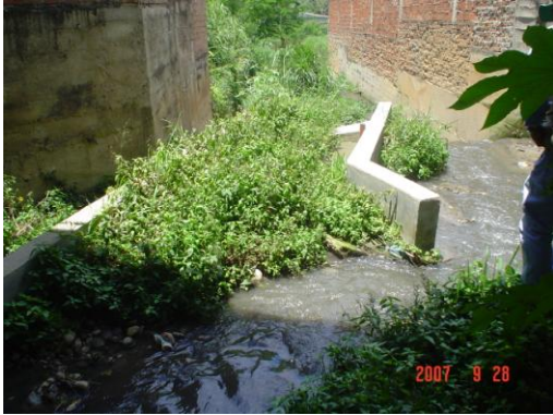
Antes de las obras
