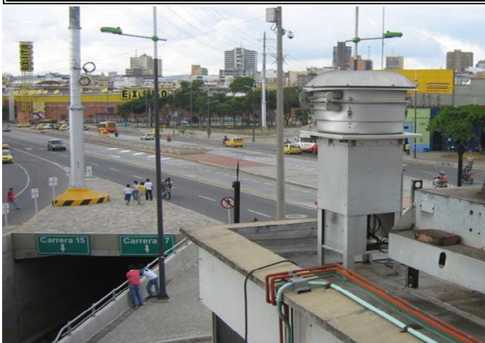
HiVol instalado en la intersección vial de la Diagonal 15 con carrera 17
