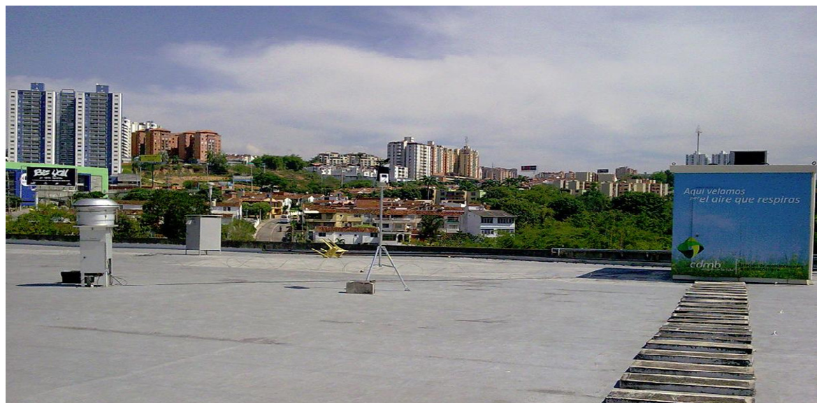
Estacion instalada en la Terraza del Edificio Telebucaramanga-Cañaveral
