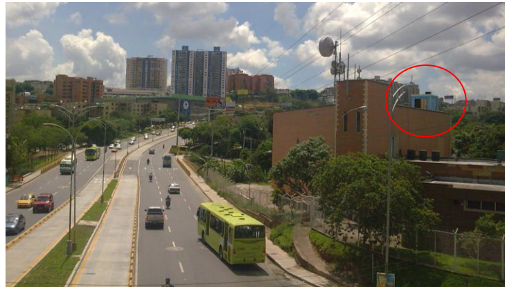
Fig 8. Estación Automática Cañaveral: Edificio Telebucaramanga sede sur
