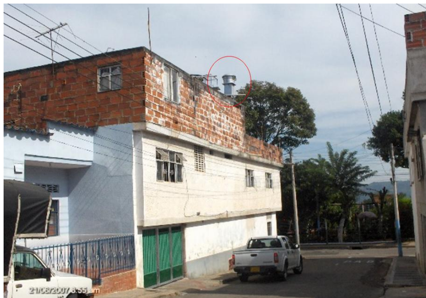
Fig 12. Estación Manual La Joya: Carrera 11 Occ # 36-04
