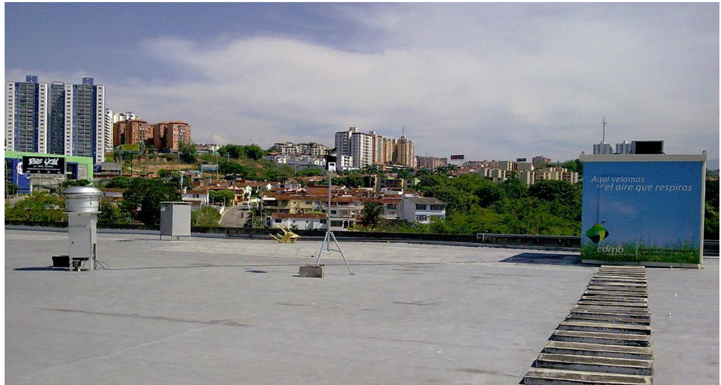
Estacion instalada en la Terraza del Edificio Tebucaramanga-Cañaverál
