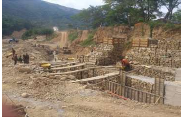
Figura 33. Obras Ejecutadas Mediante Convenios Inter-Institucionales
