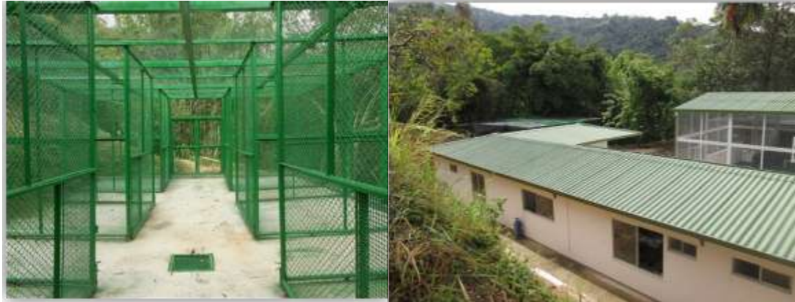
Figura 48. Vista de las nuevas instalaciones del CAV-CEARFS.
