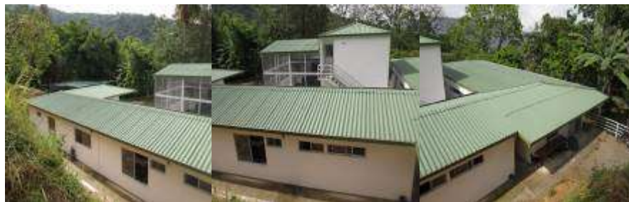
Figura 52. Panorámica de las instalaciones del Nuevo CAV-CEARFS. Abajo: Cuarto de bodega de guacales, batería de baños y cafetería
