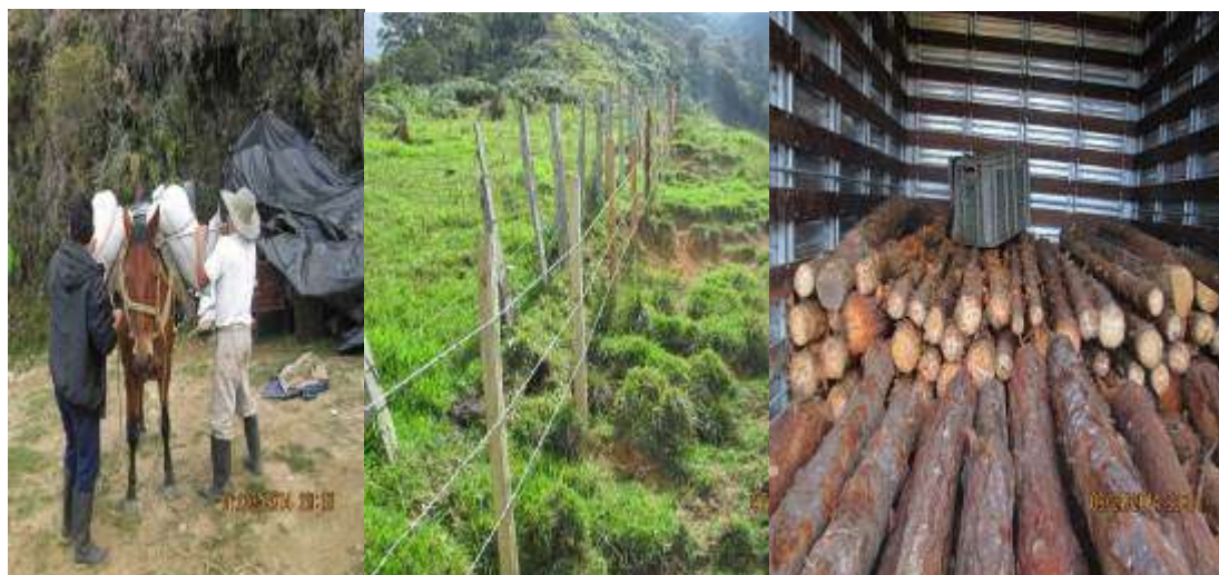
Figura 24. Transporte de materiales e hincado de los postes para aislamiento
