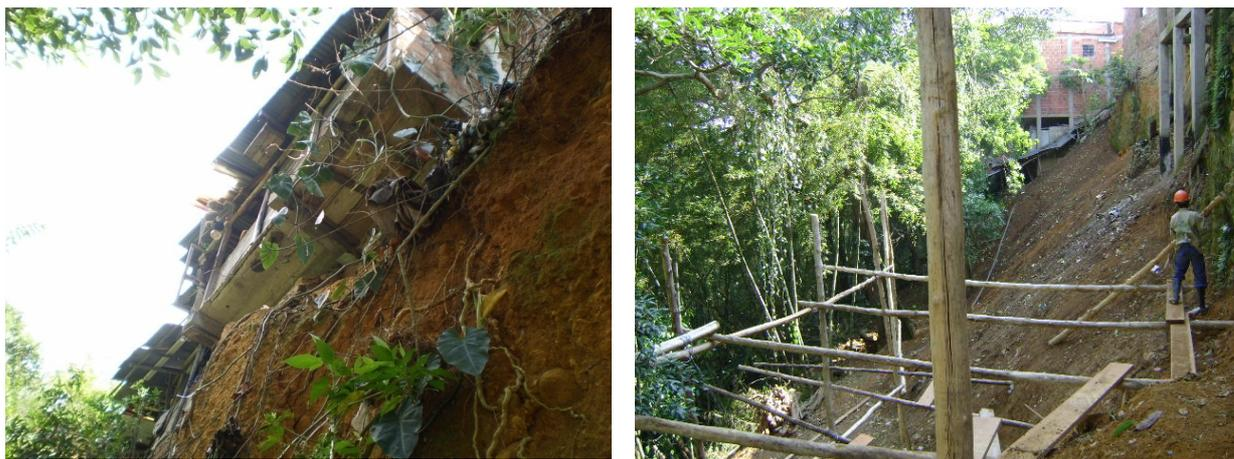
**Figura 4. Vista parcial de obras de estabilización de taludes en el barrio San Gerardo-Bucaramanga**
