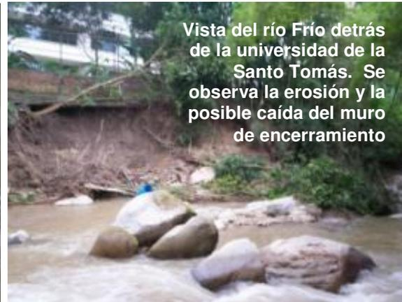
Vista del río Frío detrás de la universidad de la Santo Tomás. Se observa la erosión y la posible caída del muro de encerramiento
