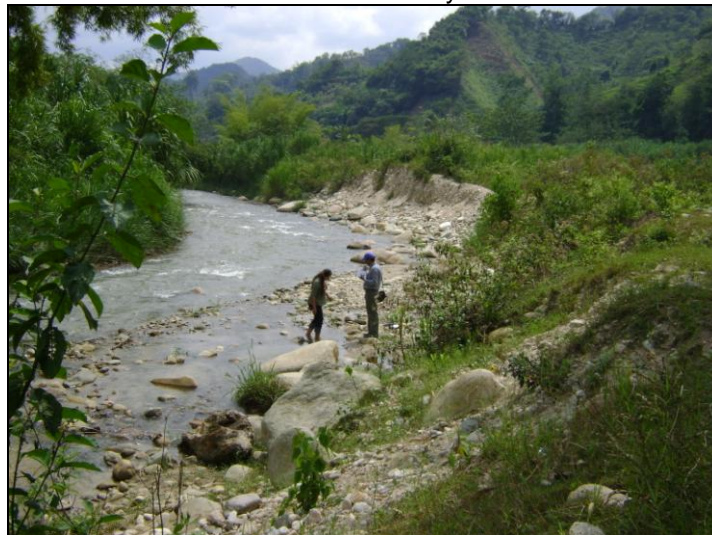
Foto No. 4.1. Socavación río Playón - Barrio Nuevo.
