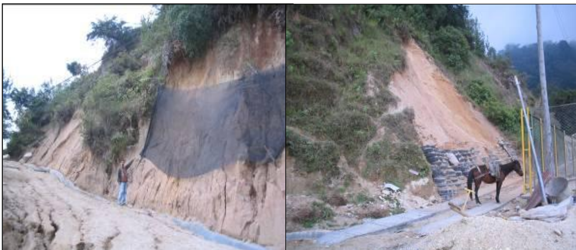
Fotografía 15. Fenómenos de remoción en masa por apertura de carretables veredales en la vereda Aguablanca, Municipio de Floridablanca.
