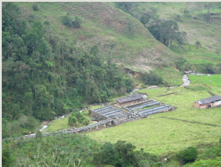
Foto 5.5. Vista general de una truchifactoria sobre el río de Oro.
