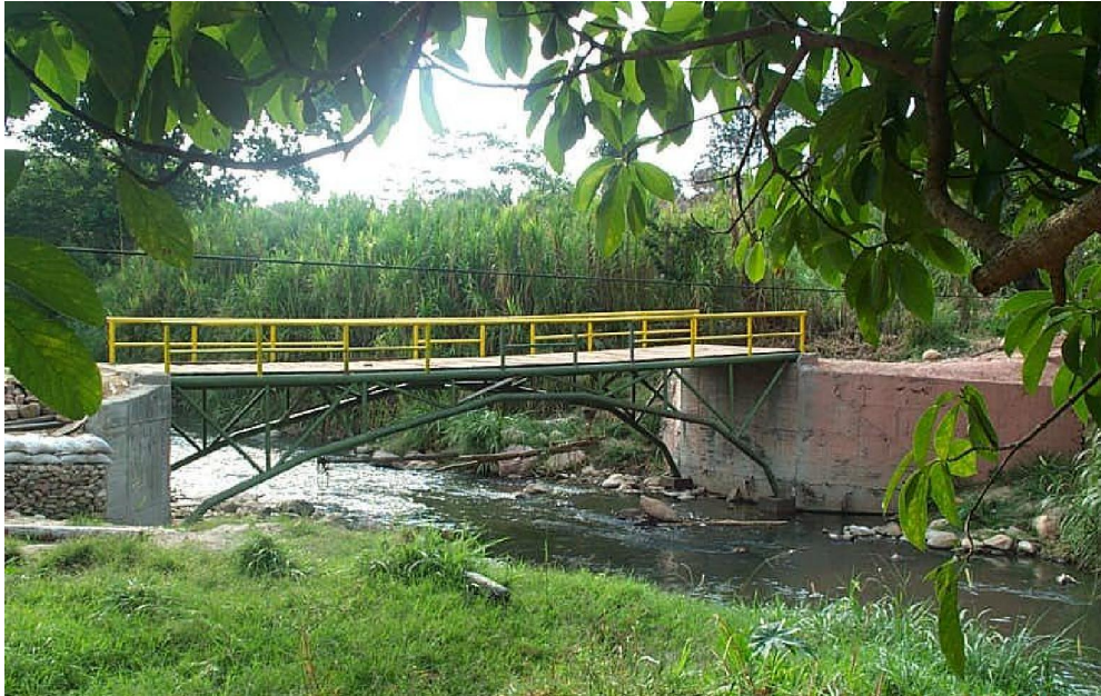
Fotografía 4.25. K10+356. Puente nuevo.
