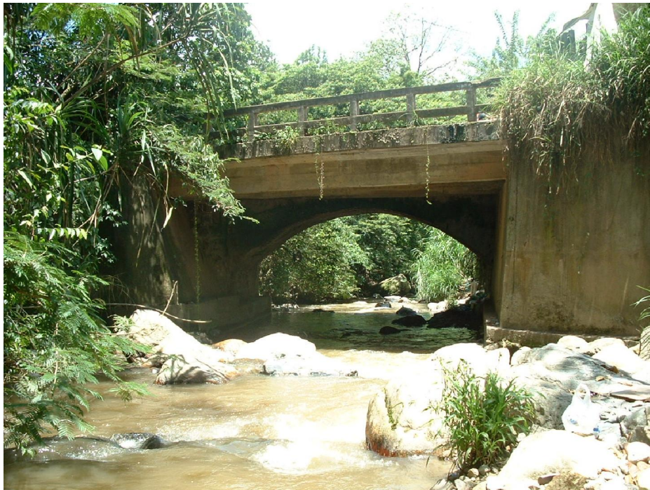
Fotografía 4.20. K1+730 Puente urbano Piedecuesta sobre carrera 6.
