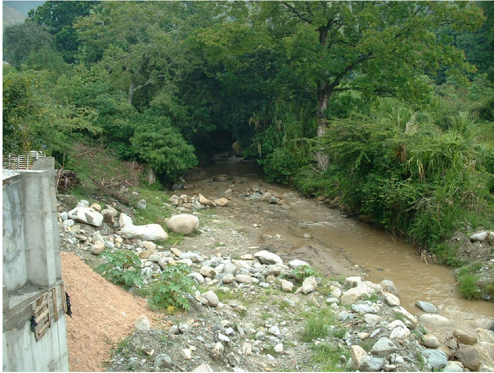
Fotografía 5.5 Sector Puente El Conquistador
