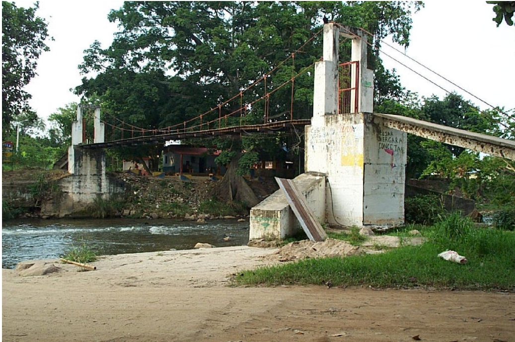
Fotografía 4.29 Puente peatonal junto a la batea del balneario El Palenque. K25+016
