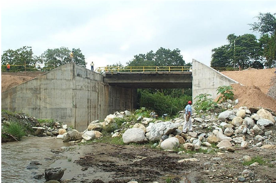
Fotografía 4.16 K0+355. Puente El Conquistador Vía Bucaramanga – Bogotá.
