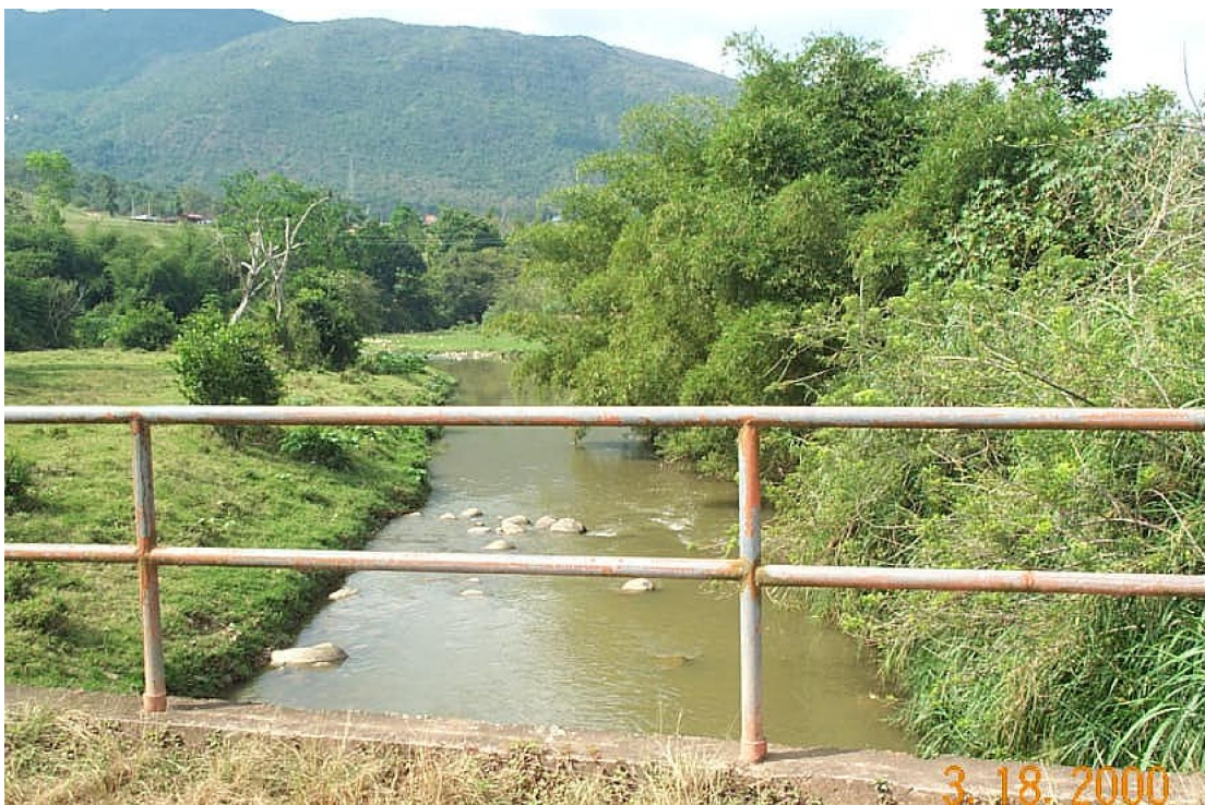
Fotografía 4.24. K8+345. Conexión a Vereda Malpaso.
