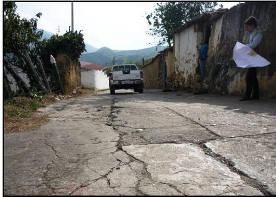
Foto 12. Grietas en las calles y desplazamiento de los muros de la vivienda localizada en la corona de desprendimiento de un antiguo deslizamiento rotacional.
