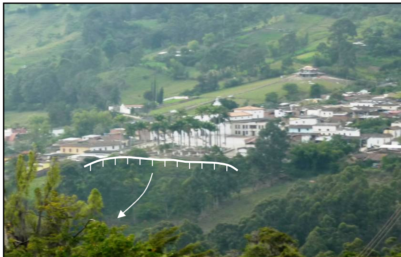
Foto 8. Deslizamiento rotacional que se presenta en la parte baja del parque principal del pueblo.
