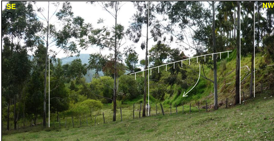
Foto 10. Corona de desprendimiento del deslizamiento rotacional activo mayor, localizado en la parte baja del parque principal de Suratá.
