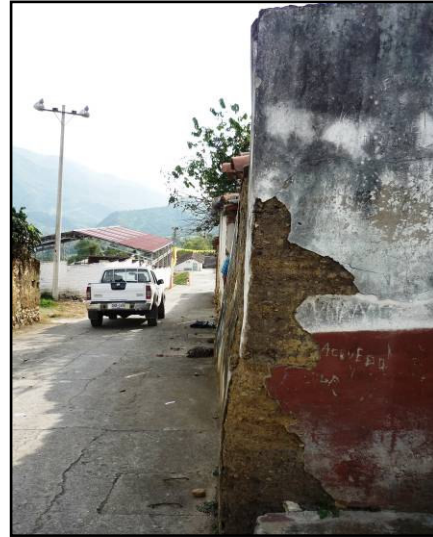
Foto 12. Grietas en las calles y desplazamiento de los muros de la vivienda localizada en la corona de desprendimiento de un antiguo deslizamiento rotacional.
