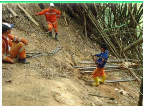
Vista de las Obras de Drenes de Penetración en el Barrio Balconcitos
