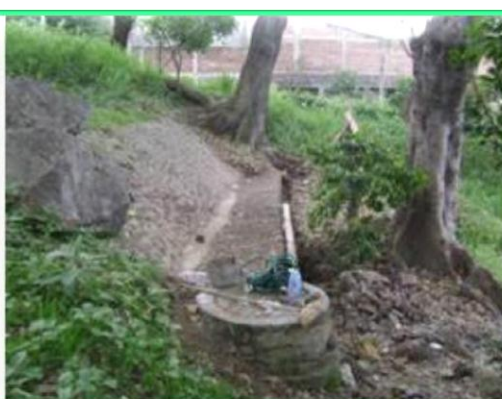
Vista de las Obras de Mantenimiento a Sistemas de Drenaje en el sector Villa Rosa
