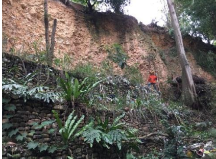
Ilustración 31 Pantalla Anclada Comuna 8 Antes
