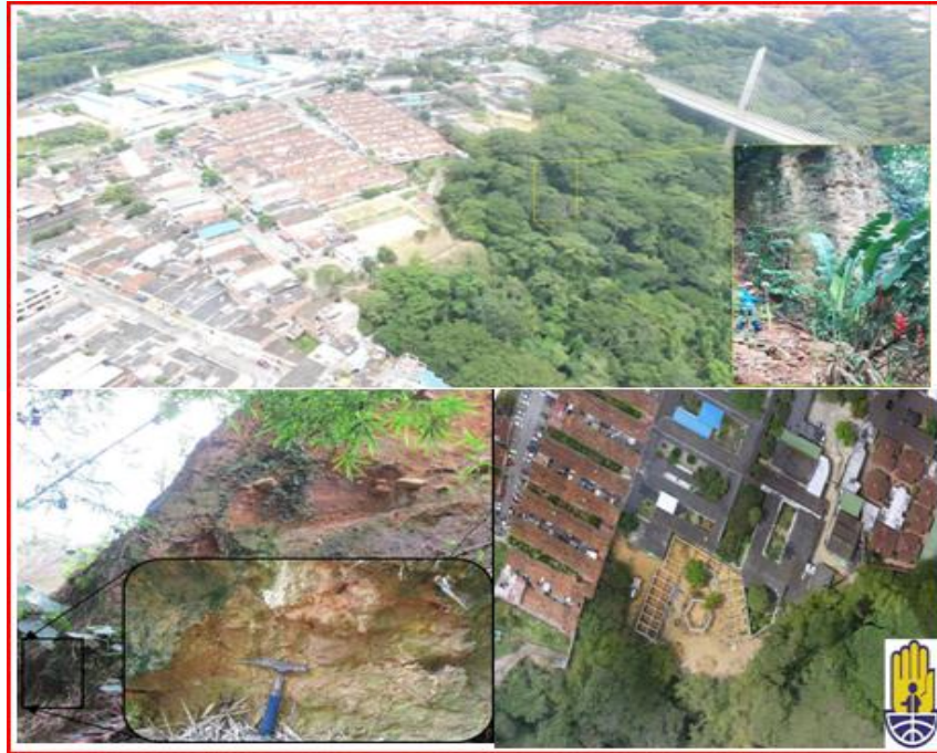
Ilustración 23 Construcción de obras de mitigación, y estabilización y consolidación de la empresa social del estado hospital psiquiátrico san camilo, taludes aferentes al barrio villa del prado y el sistema de drenaje cañada la rosita ubicados en la escarpa occidental de la meseta de Bucaramanga
