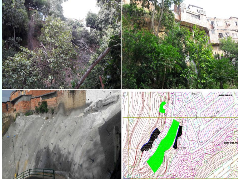
Ilustración 21 Registro fotográfico 2. Estudio Geotécnico General Y Prediseño De Obras De Estabilización En El Barrio Pablo Vi, Sector Calle 66 Y 68 Entre Carreras 10a, 10b, 10c Y 10e, Zona De Escarpa, Municipio De Bucaramanga, Santander
