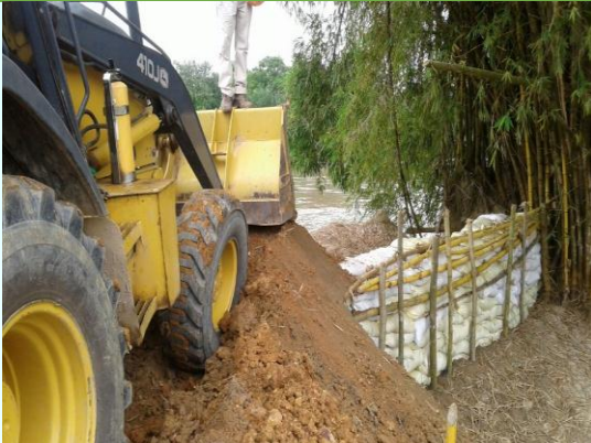
Ilustración 29 Reconstrucción Jarillon Bajo Rionegro Antes
