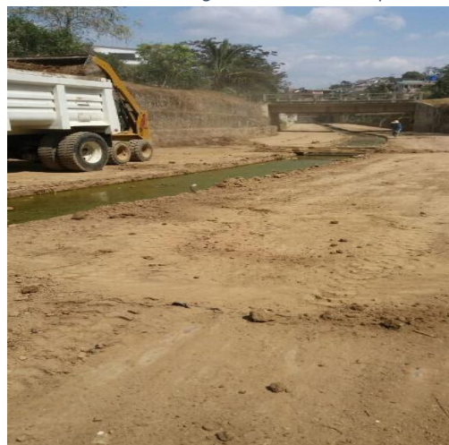
Ilustración 28 Dragado Canalización Lebrija Después
