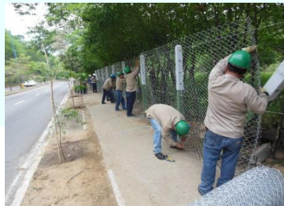
Ilustración 56. Registro fotográfico predio hacienda chimitá
