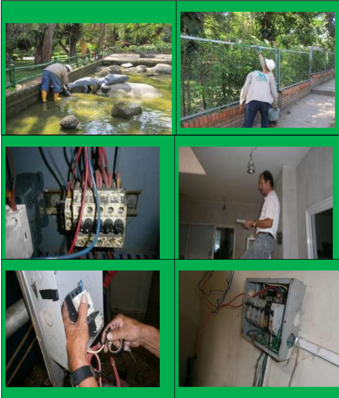
Trabajos Eléctricos Predios Varios
