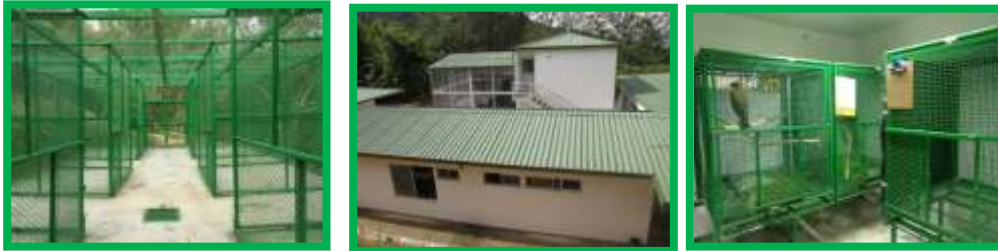
Adecuaciones de instalaciones en el nuevo CAV-CEARFS
